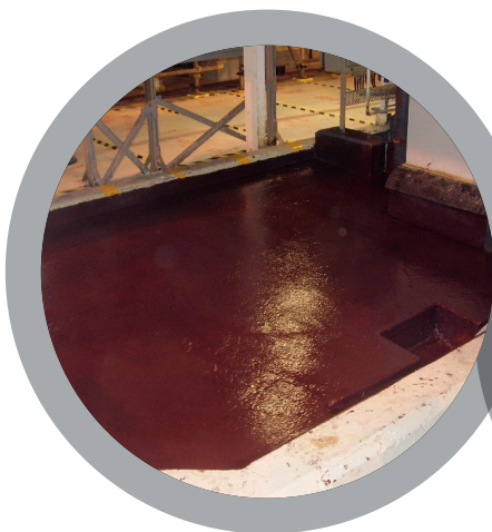
Обваловка химических хранилищ
