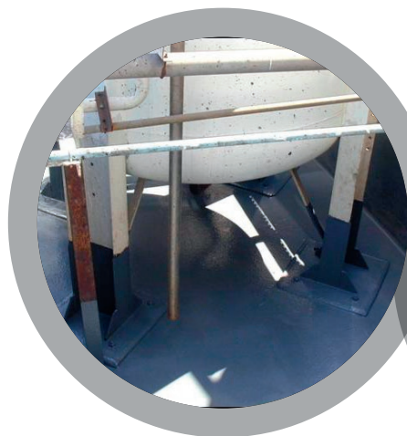
Обваловка химических хранилищ
