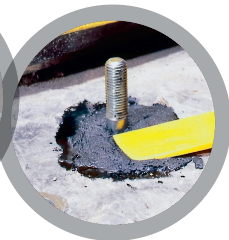
Заливка анкерных болтов
