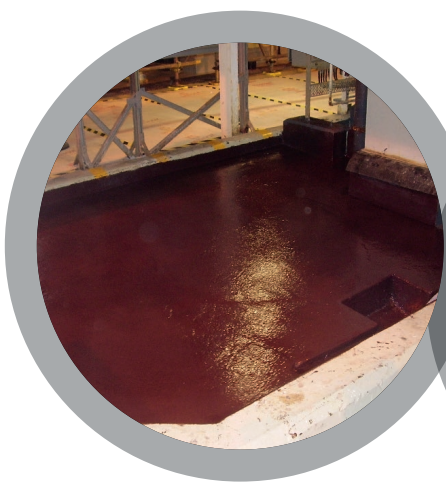
Обваловка химических хранилищ
