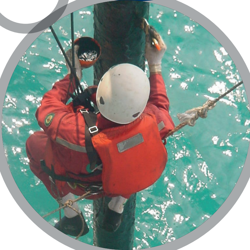
Ремонт морского стояка
