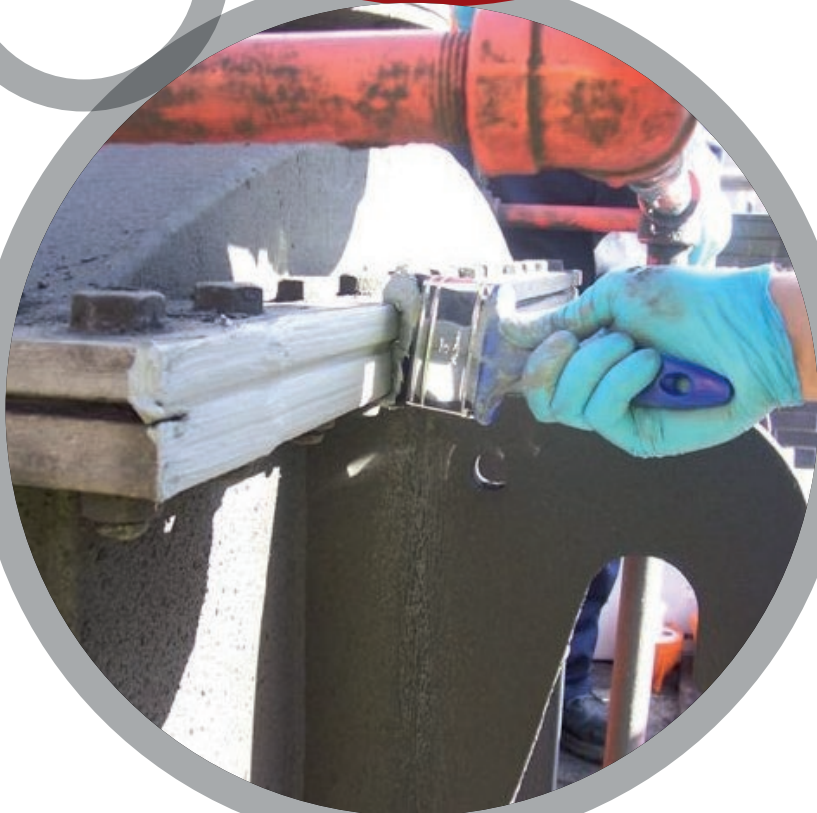
Герметизация фланцевых соединений
