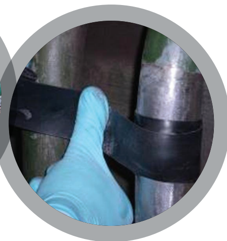
Устранение течи трансформаторного масла
