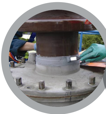
Герметизация соединения
