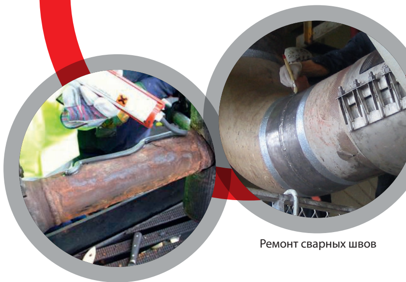
Приклеивание металлических заплаток
