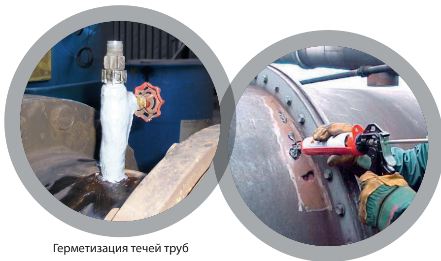
Заполнение коррозионных язв
