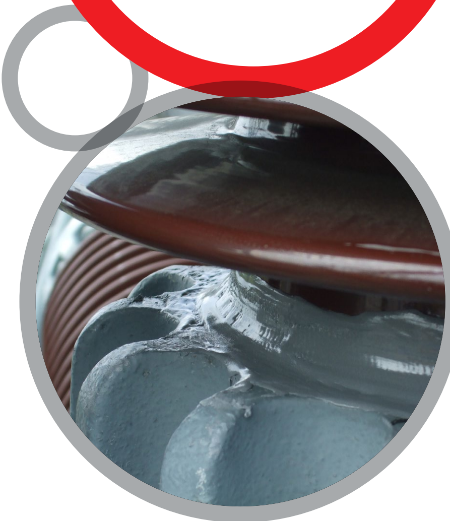
Герметизация соединения изолятора
