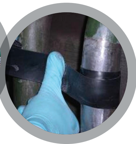
Устранение течи трансформаторного масла
