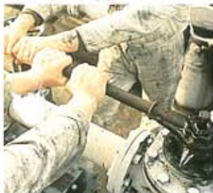
Разборка заклинивших или спекшихся деталей
