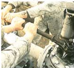
Разборка заклинивших или спекшихся деталей
